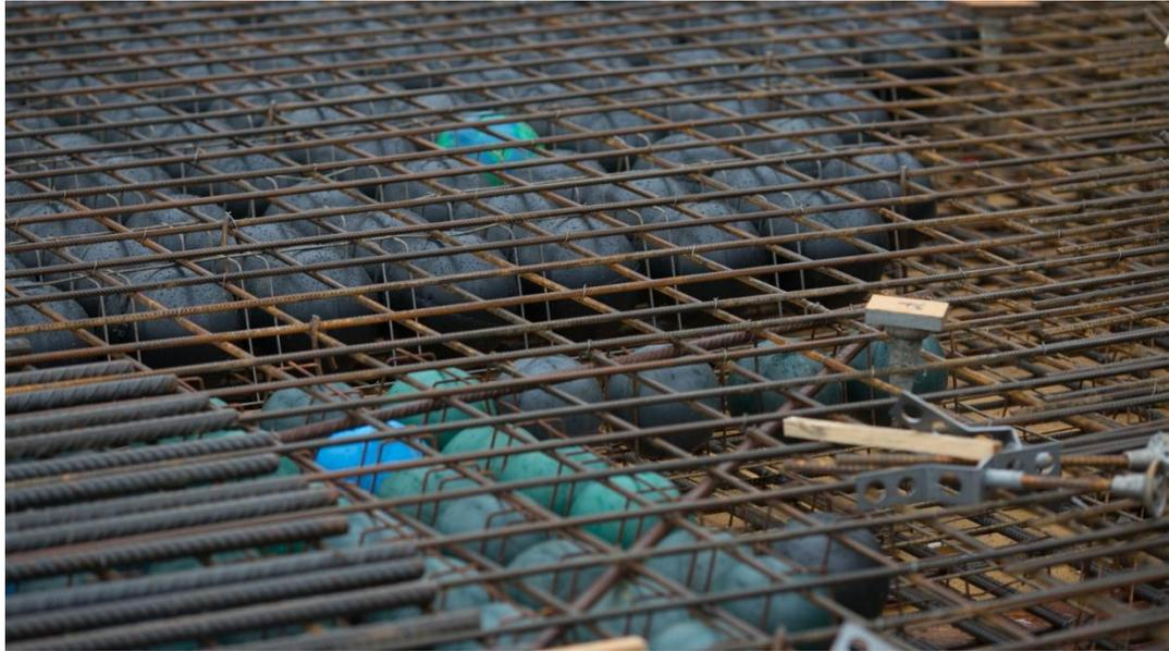
Abb. 46: Cobiax-Deckenkonstruktion zur Einsparung von Beton und Stahl
