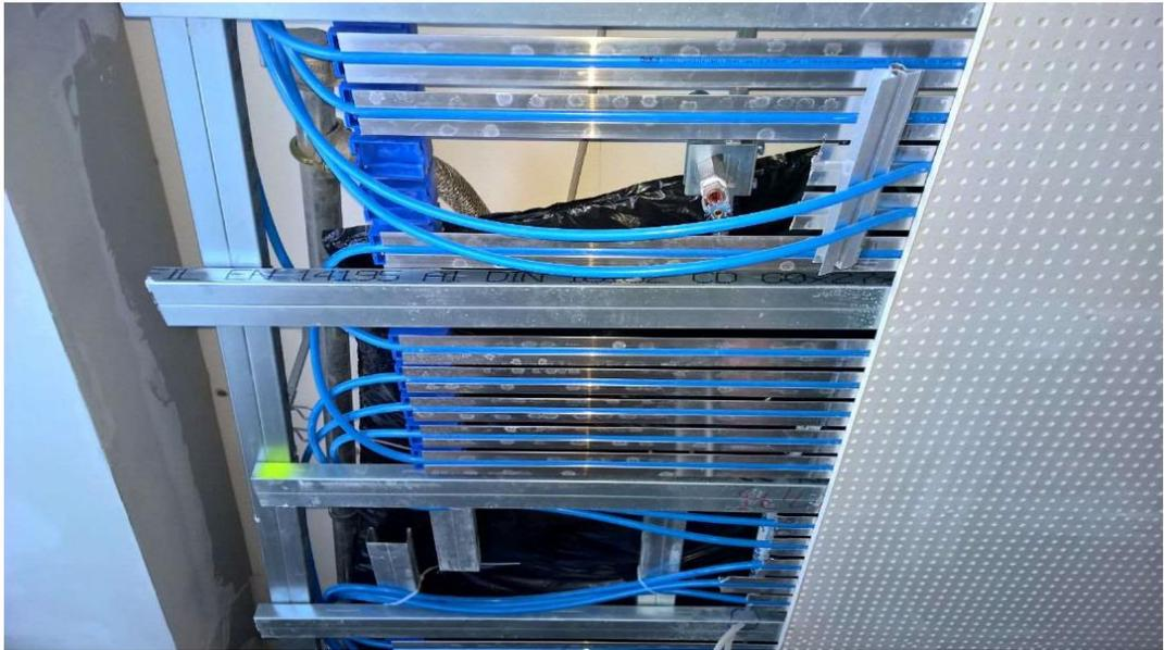
Abb. 43: PCM-Kühldecken in den Besprechungsräumen des Bauteils Forschungszentrum
