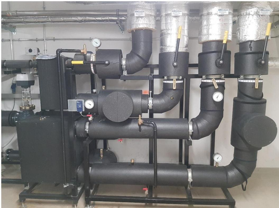
Abb. 42: Übergabestation mit interner Kaskadierung  $55/35^{\circ}\text{C}$  (u.) und  $35/25^{\circ}\text{C}$  (RLT, o.)
