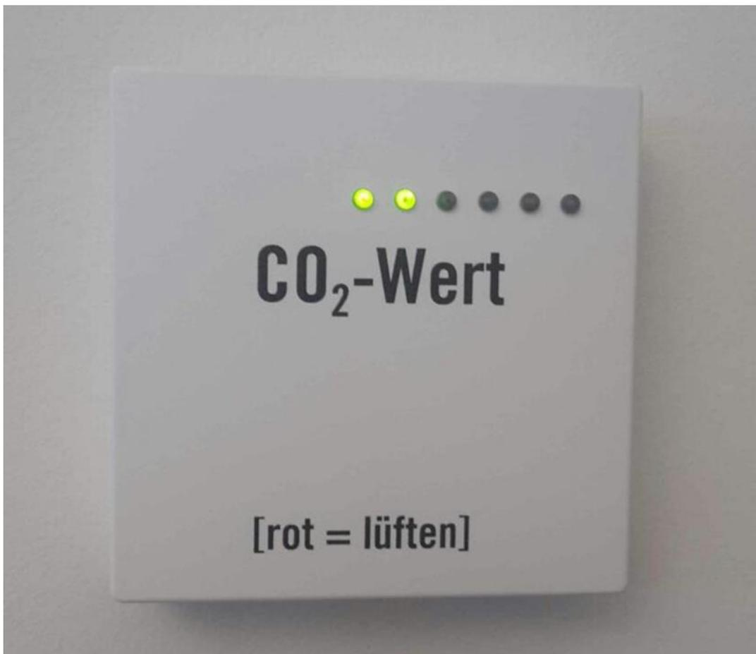
Abb. 53: CO<sub>2</sub>-Ampel zur direkten Information der Nutzer mit Aufzeichnung durch die GLT.
