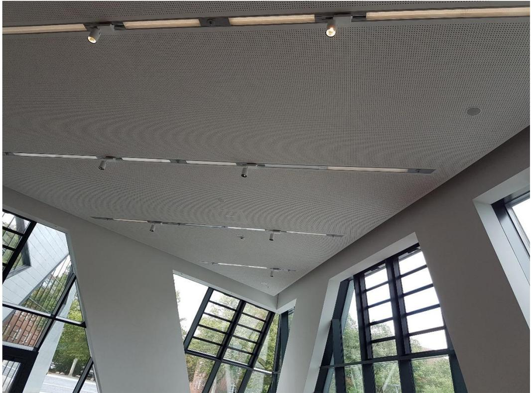
Abb. 48: Tageslichtabhängig gesteuerte Lichtbänder im Foyer (gedimmter Zustand bei mittlerem Tageslichtangebot)
