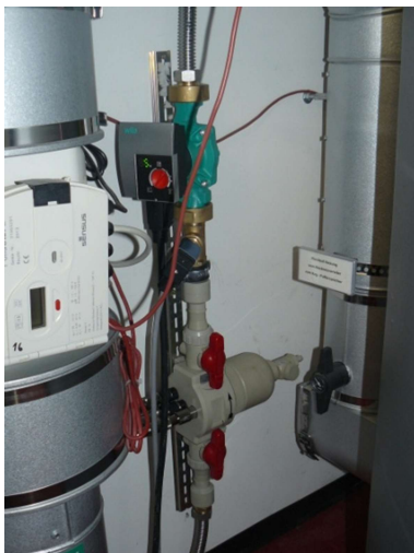
Abb. 62: Montageort des Fequan-Sensors für das Heizsystem. Die Anbindung erfolgte über die Entlüftungsleitungen mit Edelstahlwellrohr.
