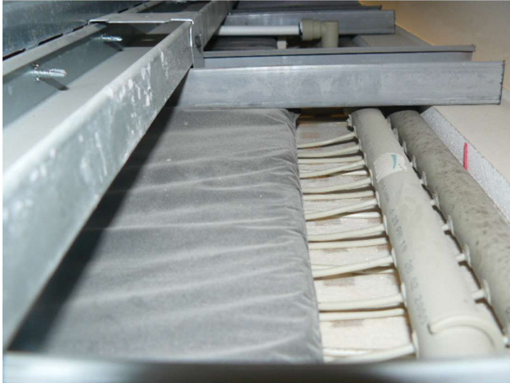
Abb. 25: Sauerstoffoffenes Sekundärsystem mit Kapillarmatten zum Heizen und Kühlen – korrosionsfest ausgeführt (bis auf Graugusspumpe), unproblematisch
