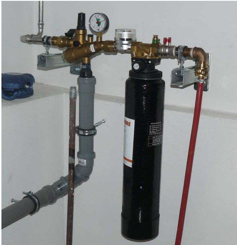
Abb. 67: Manuelle Nachspeisung mit Entsalzungskartusche
