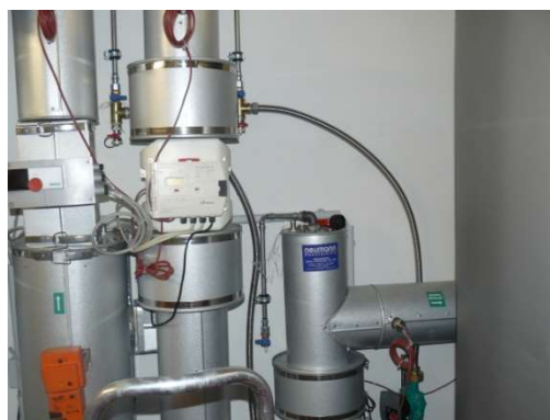
Abb. 62: Montageort des Fequan-Sensors für das Heizsystem. Die Anbindung erfolgte über die Entlüftungsleitungen mit Edelstahlwellrohr.
