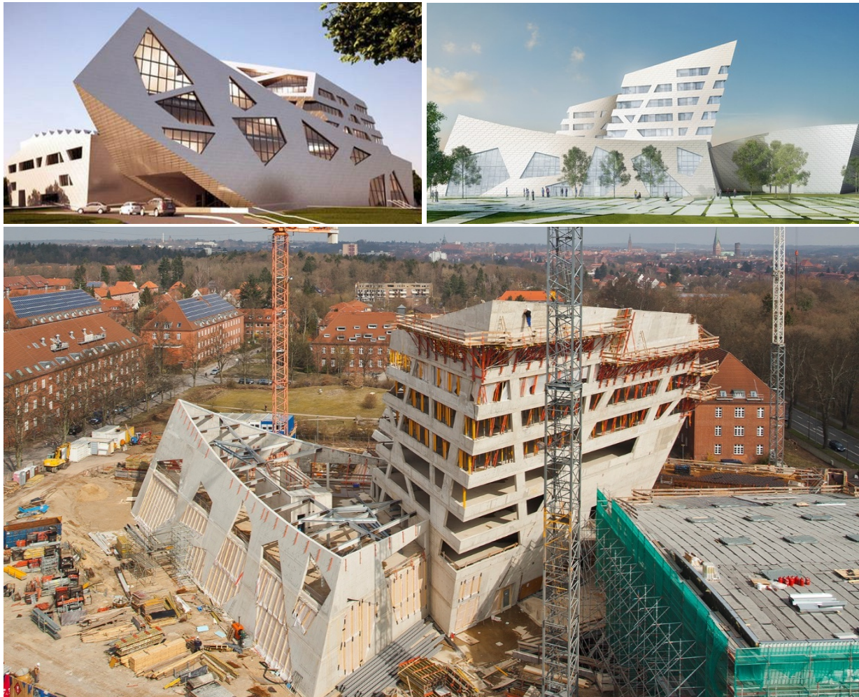
Abbildung 1: Neues Zentralgebäude der Leuphana Universität Lüneburg (Entwurf und im Bau [Mai 2015]) mit Kältebedarfsreduktion durch selbstverschattende Fassade und intelligentes Glas
