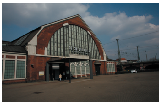
Wechsel des Veranstaltungsortes in die Deichtorhallen Hamburg / Change of location to the Deichtorhallen Hamburg
