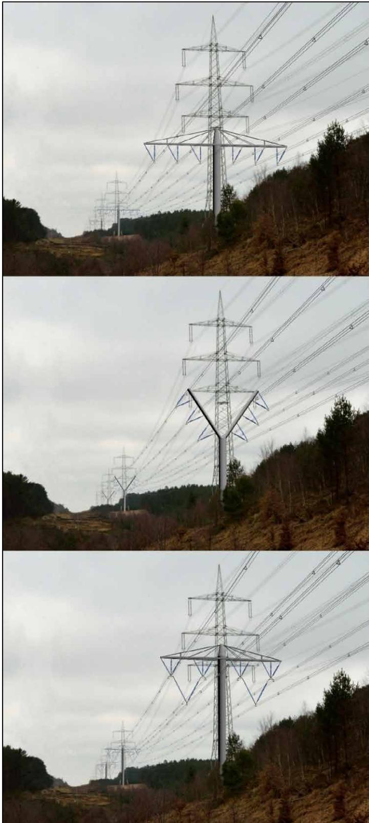
Abb. 58: Visueller Vergleich der innovativen Mastsysteme mit den konventionellen Tonnenmasten im Landschaftstyp 2.1 (Einebenenmast, oben; Y-Mast, mittig; Sternkettenmast, unten).
