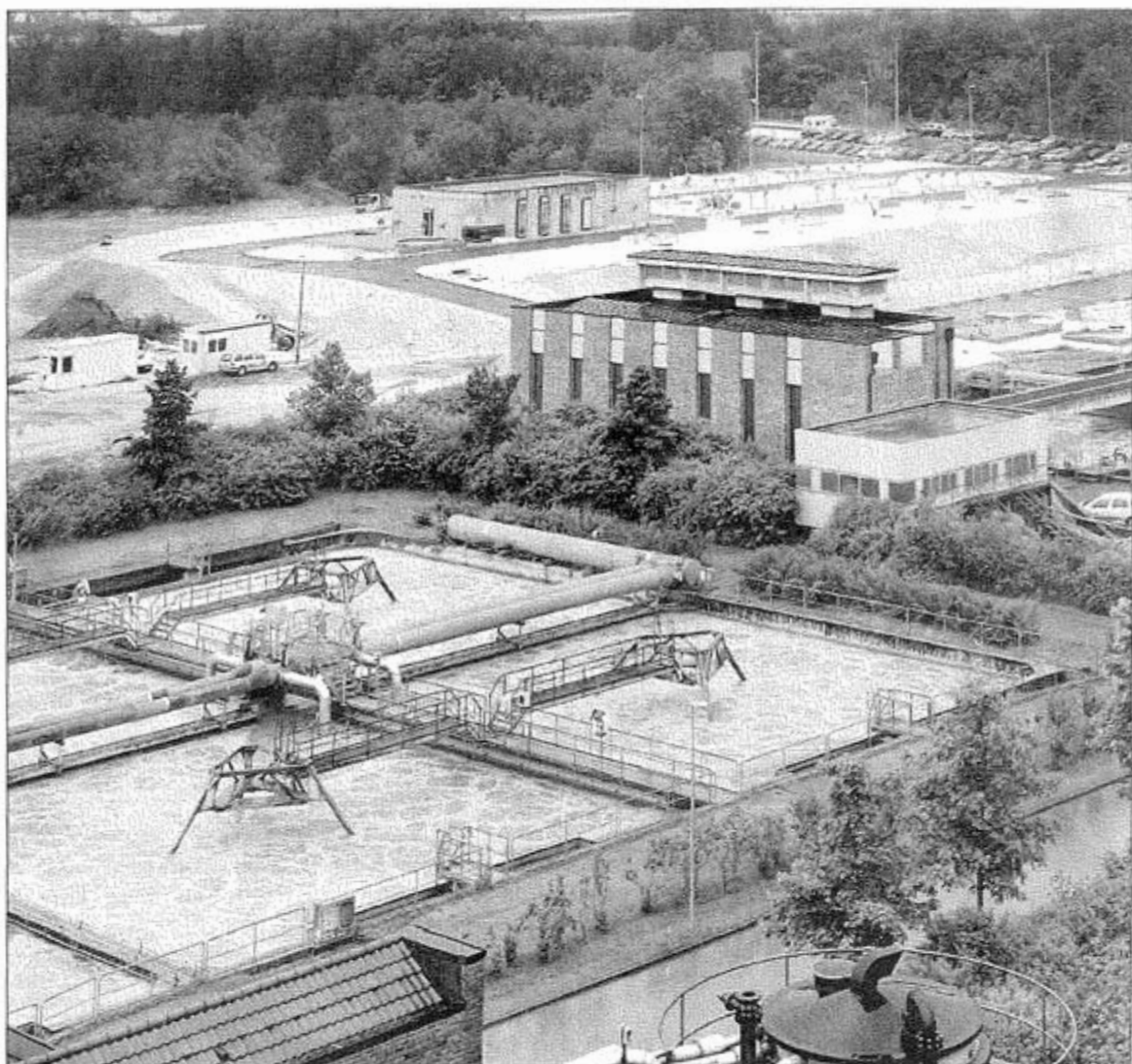
Auf der neuen Erweiterungsfläche des Klärwerks Steinhäule sind bereits die abgedeckten Klärbecken zur Stickstoff-Elimination in Betrieb. Im Vordergrund ein Becken zur biologischen Abwasserreinigung. FOTO: VOLKMAR KÖNNEKE
